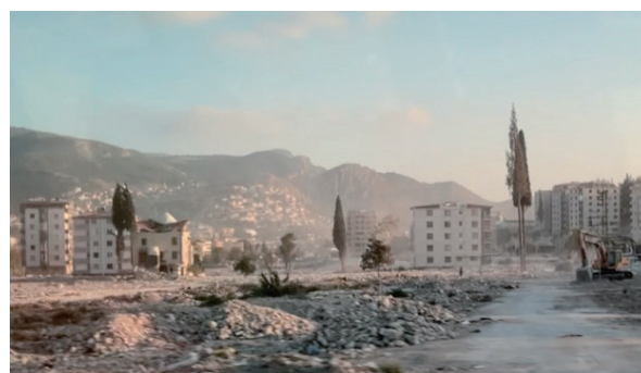
幹線道路沿いの瓦礫の中に残された建物 (ハタイ県/写真は筆者撮影)
